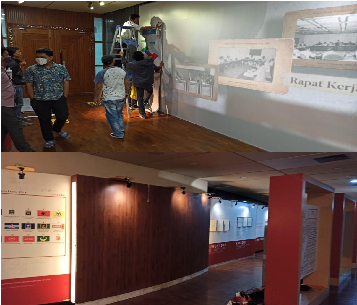
Gambar 36 Pekerjaan revitalisasi tahap II
