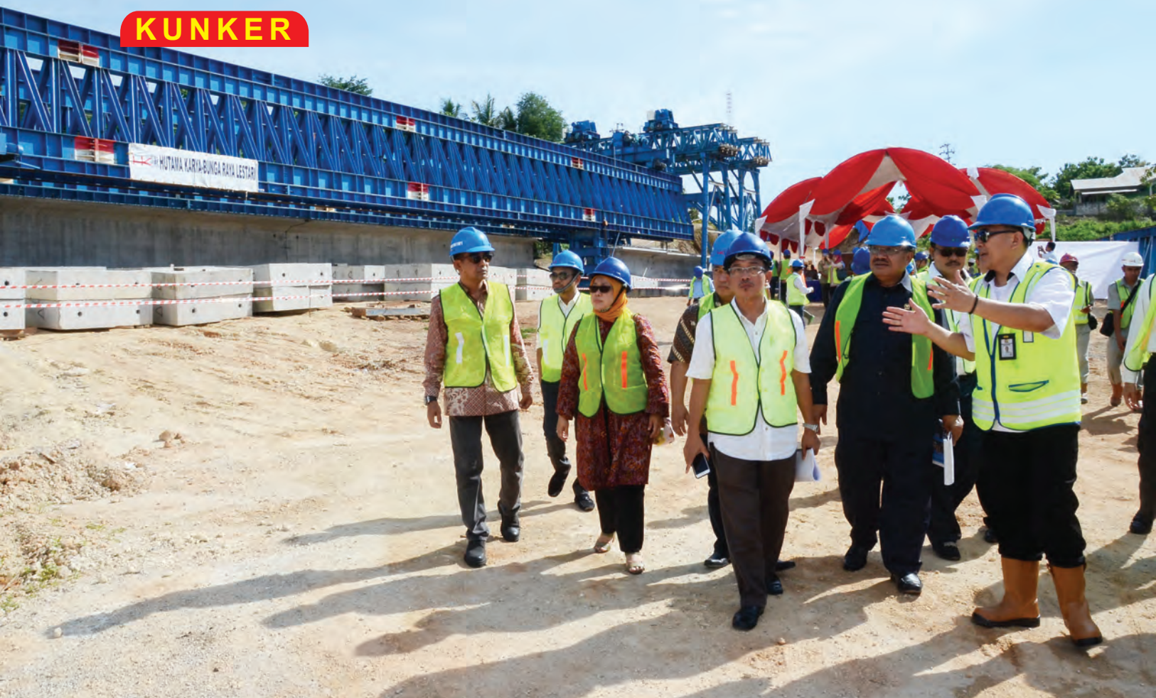
Tim Kunker Komisi VI meninjau proyek Jembatan Petuk I, Kupang
