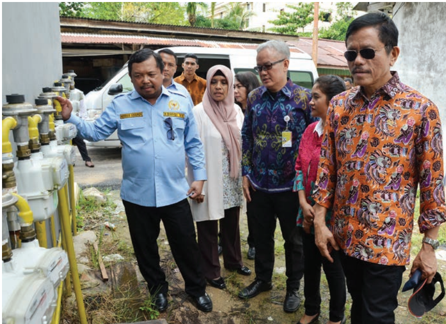
Tim Kunker Komisi VII DPR meninjau jaringan distribusi gas bumi untuk rumah tangga (jargas) di Kalimantan Utara
