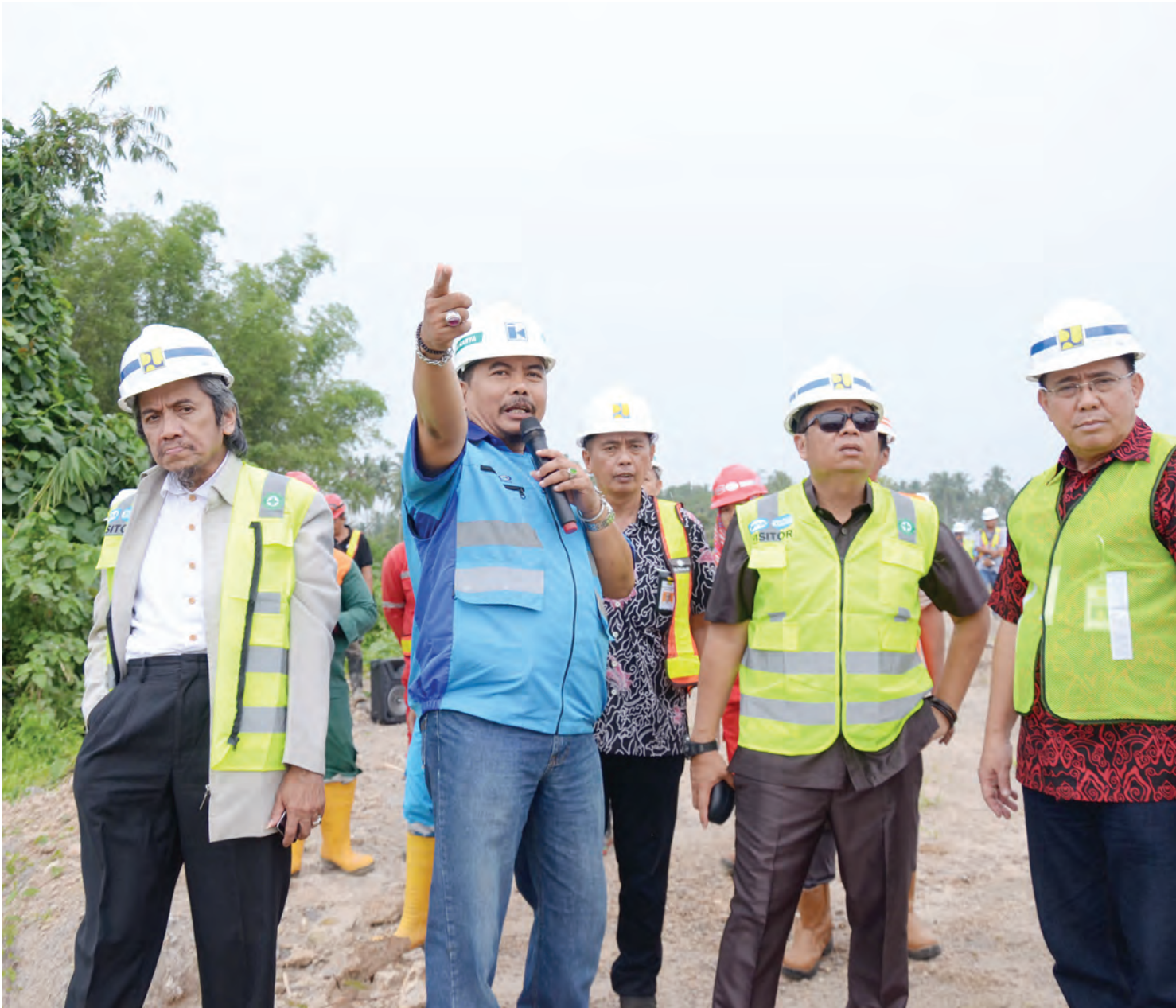
Tim Kunjungan Kerja Komisi V DPR RI meninjau pembangunan Tol Manado-Bitung (27/10).
