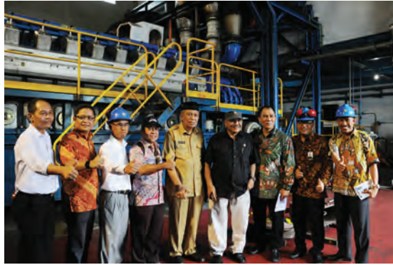
Tim Kunker Komisi VI DPR RI meninjau PLTD/G Gunung Beluh Tarakan
