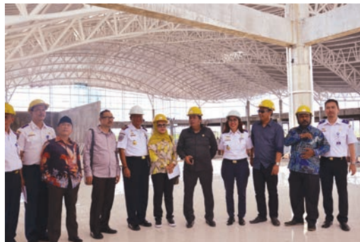
Tim Kunker Komisi V DPR RI meninjau pembangunan terminal baru Bandara Tjilik Riwut Palangkaraya
