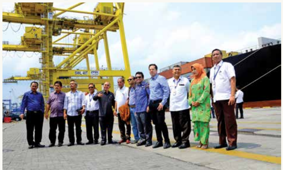
Tim Kunjungan Spesifik Komisi VI meninjau fasilitas pelabuhan yang dikelola PT Pelindo I di Medan, Sumut
