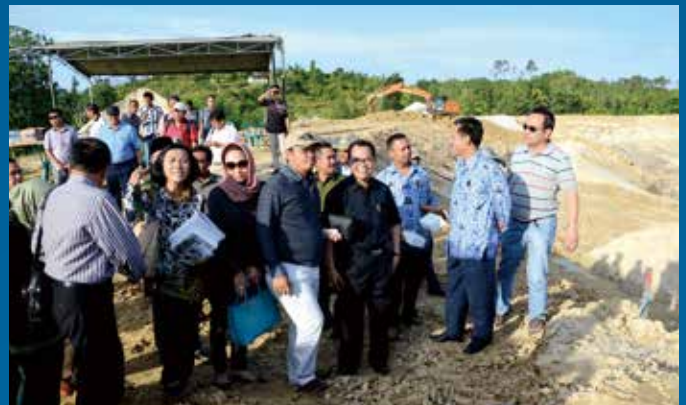
Tim Kunjungan Kerja Komisi V DPR RI dipimpin Laurens Bahang Dama meninjau pembangunan Embung Bengawan di Tarakan Kalimantan Utara. Senin (28/10). Foto: Iky/Parle/HR.
