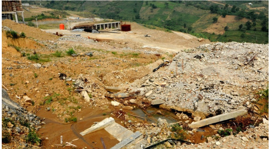
Lokasi amblasnya tanah Hambalang
