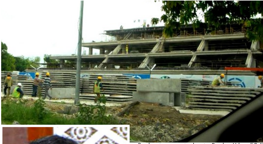
Pembangunan pengembangan Bandara Udara di Bali
