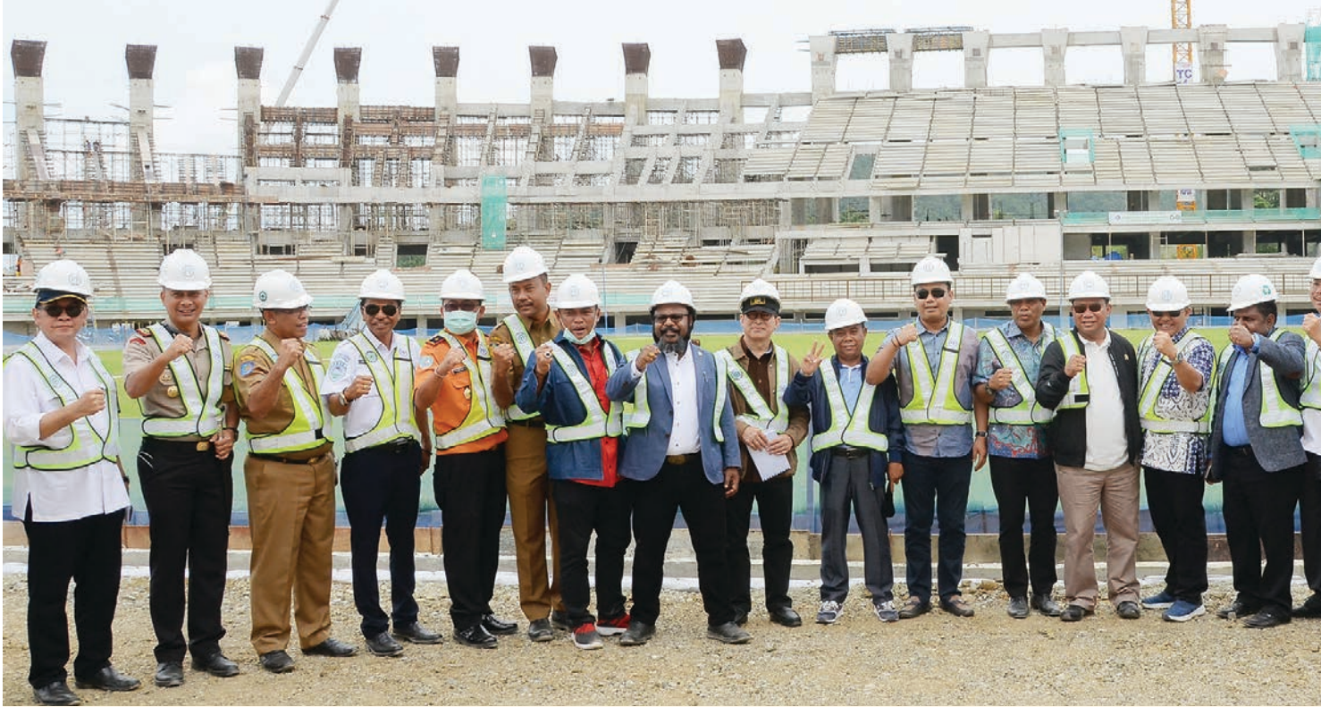
Tim Kunker Komisi V DPR RI meninjau pembangunan Stadion Papua Bangkit
