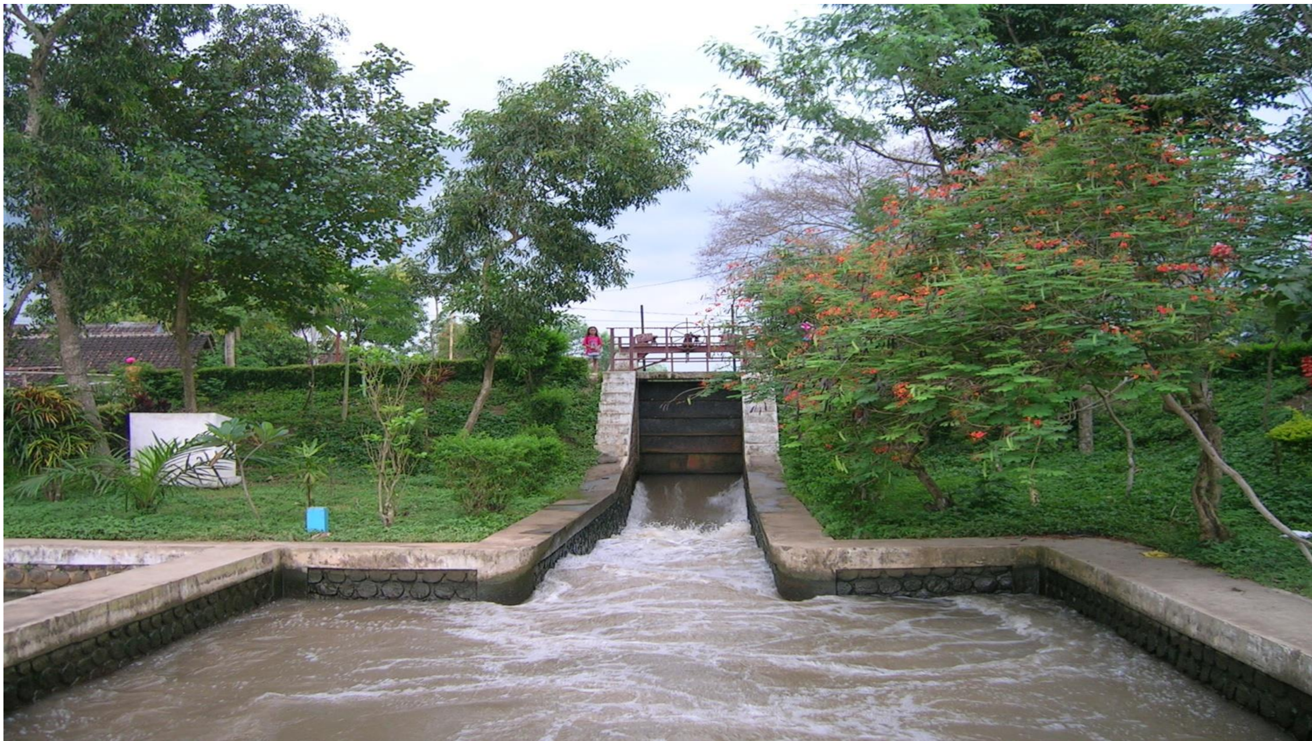
Foto Bangunan Terjun Irigasi – Potensi 60 kW
