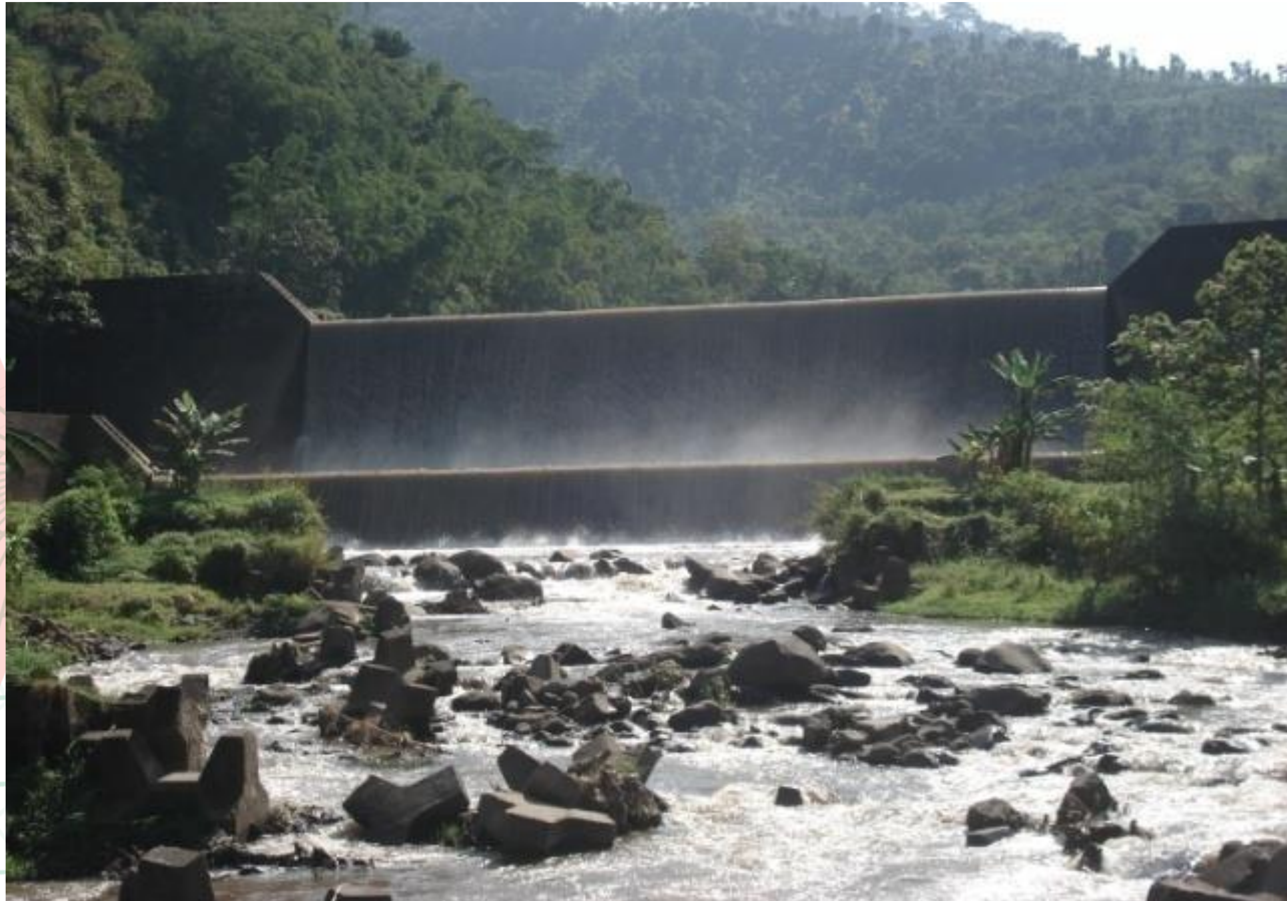
Foto Bangunan Checkdam – Potensi 0,50 MW
