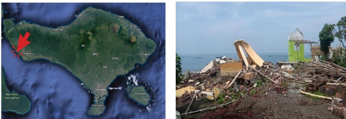
Gambar: Lokasi abrasi di Pantai Pebuahan Desa Banyubiru (kiri) dan Kondisi setelah terjadi abrasi (kanan)
