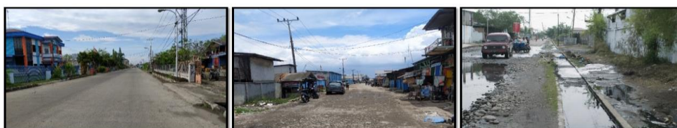
Foto. Kondisi jalan belum seluruhnya dilakukan penegerasan kondisinya sangat memprihatinkan Perlu peninggian dan pengerasan
