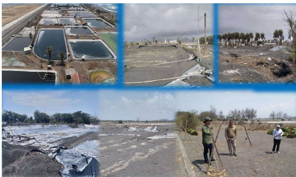
Gambar 1. Kondisi Awal Sebelum RHL
