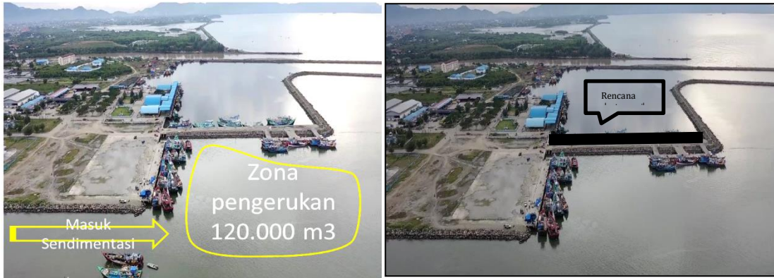
Gambar 4. Kondisi Pendangkalan Kolam Tambat Labuh dan Rencana Pembangunan Sheet Pile PPS Kutaraja-Lampulo
